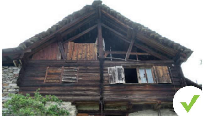
Il cambiamento di destinazione del sottotetto da deposito a locale abitabile comporta la chiusura del timpano. Il tipo di chiusura e il modo in cui la chiusura viene messa in opera sono fondamentali per scongiurare l'alterazione tipologica dell'intera facciata.
