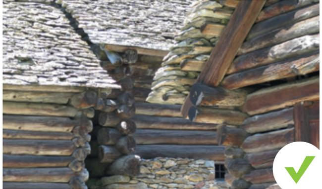
Per la ricostruzione o il completamento della carpenteria è fondamentale il rispetto delle dimensioni, degli spessori, delle sporgenze e delle pendenze. La fase di smontaggio risulta quindi essenziale, poiché è proprio in questa fase che si possono e si devono raccogliere tutti i dati che altrimenti andrebbero irrimediabilmente perduti.
