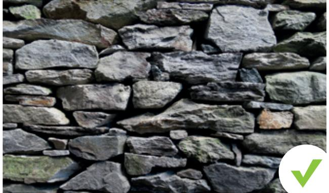
Per la ricostruzione o il completamento di murature in pietra è fondamentale disporre dello stesso tipo di materiale reperito sul posto. L'esecutore dovrà osservare il carattere della muratura e riprodurlo scrupolosamente.
