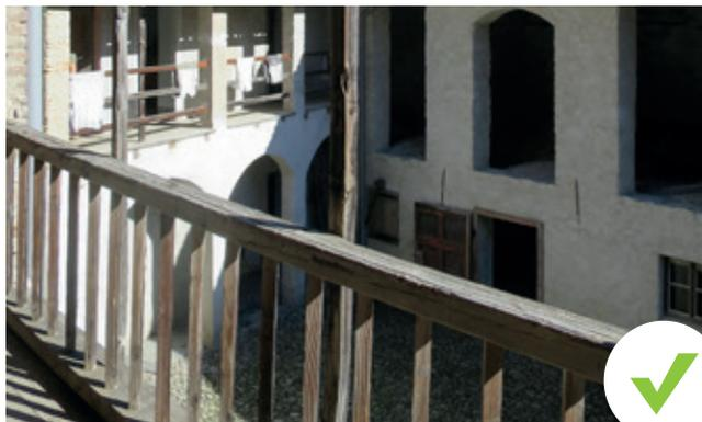
Negli edifici destinati all'abitazione erano da sempre presenti protezioni in legno. È corretto restaurare o ricostruire le strutture originali adattandole, se possibile, alle norme in vigore. Se ciò non fosse possibile, come nell'esempio sottostante, l'applicazione di una rete metallica a maglia fine risolverebbe il problema senza stravolgere la tipologia originale.
