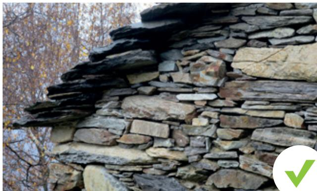
Le malte utilizzate per la muratura o per gli intonaci dovranno avere lo stesso colore e la stessa granulometria di quelle originali. Sono da evitare malte di cemento grigie. Con l'utilizzo di inerti più o meno rossi e calci più o meno brune si possono ottenere ottimi risultati. Sul mercato si trovano malte preconfezionate a base di calce, appositamente studiate per il restauro. L'ideale sarebbe prelevare un pezzetto di quella originale da mostrare al rivenditore.
