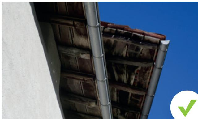
Non si dovrebbe escludere a priori l'utilizzo della vecchia carpenteria. Un adeguato recupero delle parti sane unito alla sostituzione delle parti deteriorate, oltre a migliorare l'aspetto finale, farebbe risparmiare. Se, però, si optasse per una carpenteria completamente nuova è fondamentale che i nuovi elementi rispecchino quelli originali nelle forme e nelle dimensioni.
