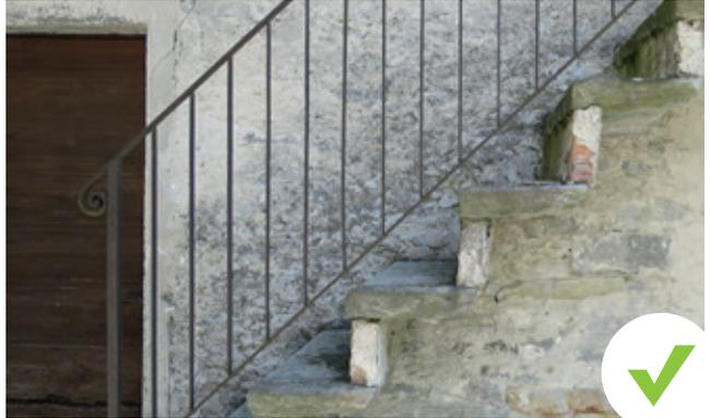
Un buon risultato per le nuove ferratine si ottiene impiegando tondini verticali del diametro di 10 millimetri, saldati a piattine orizzontali di 30x8 millimetri, con i montanti che non devono superare i 25x25 millimetri se a sezione quadrata oppure i 30x8 millimetri se a sezione rettangolare.
