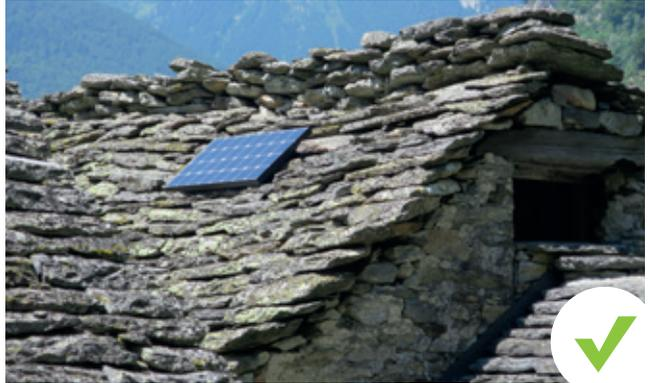
I pannelli fotovoltaici devono essere integrati in modo ordinato nelle falde del tetto, seguendone pendenza e orientamento. Se le condizioni di esposizione delle falde dovessero essere estremamente negative, è possibile posarli su un'asta, in una posizione discreta nei pressi del retro del rustico.
