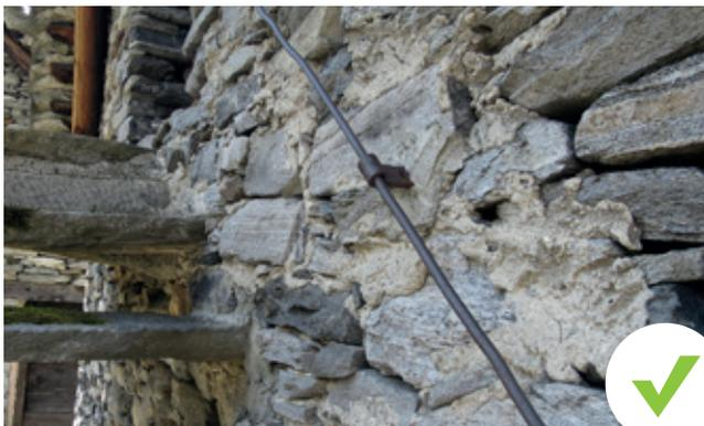
Quando il dislivello non supera il metro, è sufficiente un corrimano formato da semplici tubi di metallo. Il diametro dei tubi non deve superare i 25 millimetri, così da risultare discreto.
