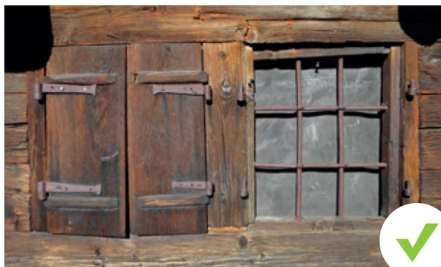
Le aperture sono composte da singoli elementi ben distinti: spalle, architravi, davanzali, ante, finestre e inferriate. Nel restauro o nella ricostruzione di un'apertura, sbagliare anche solo un elemento può compromettere l'esito generale. Per evitare di cadere in questo errore risulta quindi fondamentale osservare, rilevare e riproporre scrupolosamente i dettagli originali.
