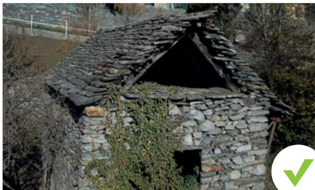
Nelle valli del Locarnese, in particolare in Valle Maggia e in Valle Verzasca, i tetti sono del tipo a puntoni (senza la trave di colmo) mentre in Leventina il tipo di copertura è detto a cavallo (munito appunto di colmo). Il timpano aperto di un tetto a puntoni è completamente libero; quello di un tetto a cavallo presenta la trave verticale di sostegno del colmo, a volte stabilizzata da saette.
