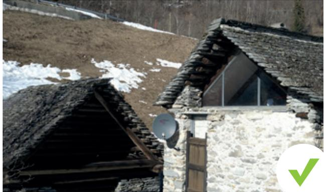
Il timpano aperto è delimitato in alto dalle travi del tetto e in basso dal coronamento del muro sottostante, sia esso in pietra o in legno. Due sono gli aspetti ai quali occorre prestare particolare attenzione: il tipo di chiusura che viene utilizzato e il punto in cui essa viene posata.
